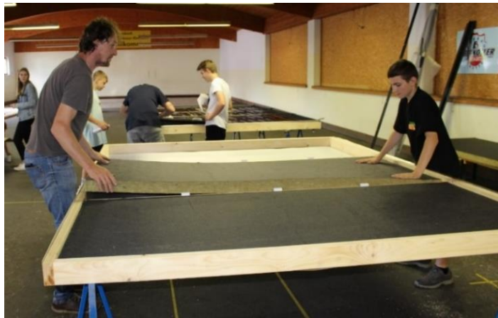
Izolacija sprejemnika sončne energije preprečuje toplotne izgube
