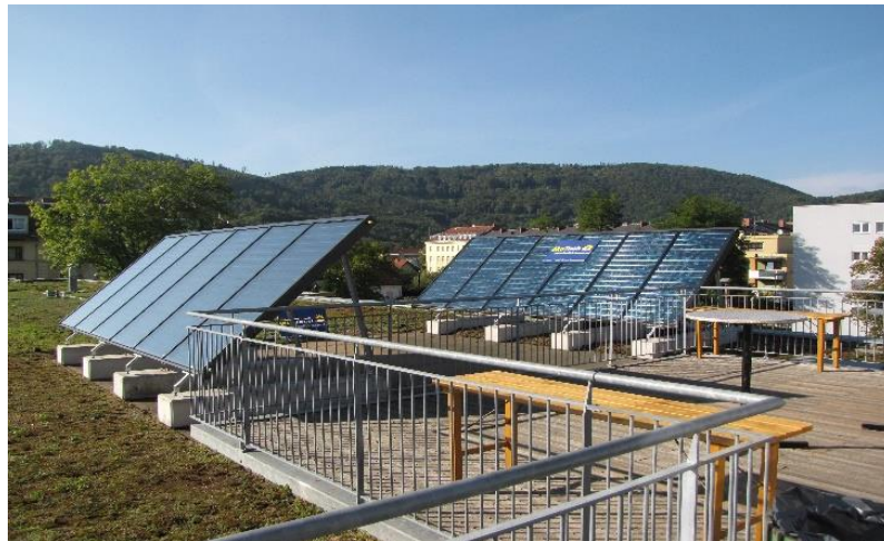
Zgrajeni sprejemniki razširjajo že obstoječi sistem na šoli Karl Morré v Gradcu (Avstrija)
