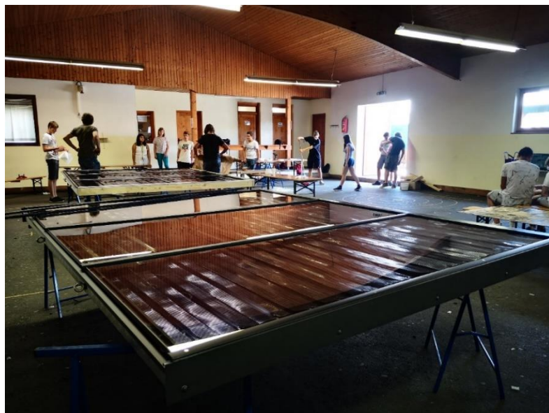
Δύο σχεδόν ολοκληρωμένοι συλλέκτες, κατασκευασμένοι από μαθητές του New Middle School Heiligenkreuz (Αυστρία)
