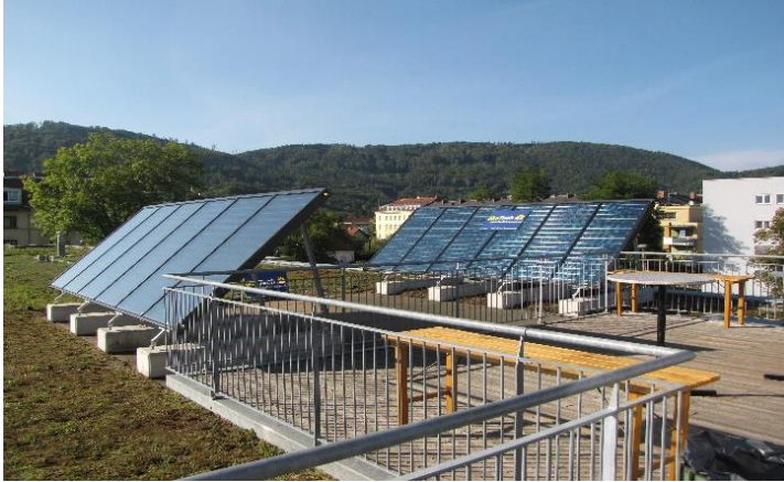
Αυτό-κατασκευασμένοι ηλιακοί συλλέκτες επεκτείνουν το υπάρχον σύστημα του Γυμνασίου Karl Morré στο Graz (Αυστρία)
