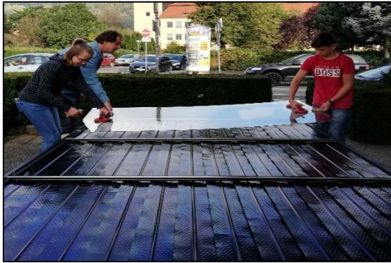
11. Καθαρισμός και τοποθέτηση του γυαλιού
