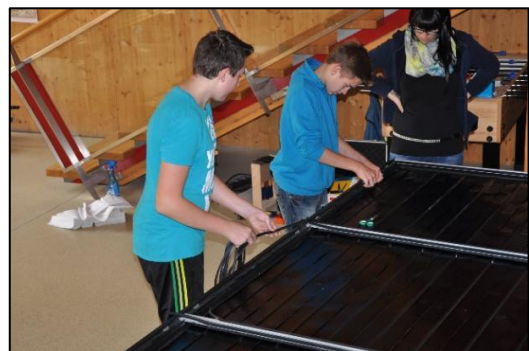
10. Τοποθέτηση μεταλλικού πλαισίου για τη στερέωση της γυάλινης πλάκας
