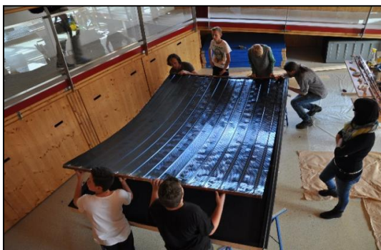
9. Τοποθέτηση της επιφάνειας απορρόφησης στο ξύλινο πλαίσιο
