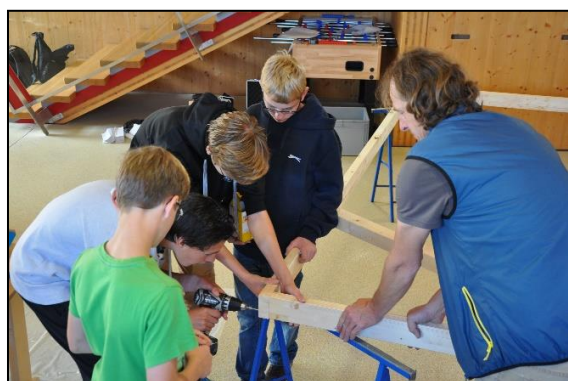
1. izgradnja lesenega okvirja
