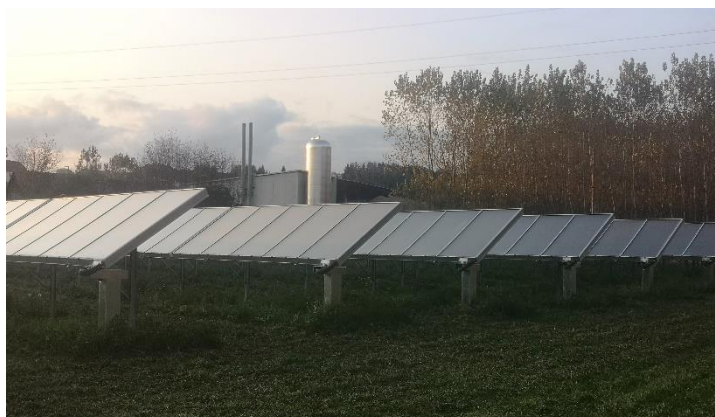
Samostojni termični solarni sistem, ki oskrbuje lokalno daljinsko gretje (Avstrija)
